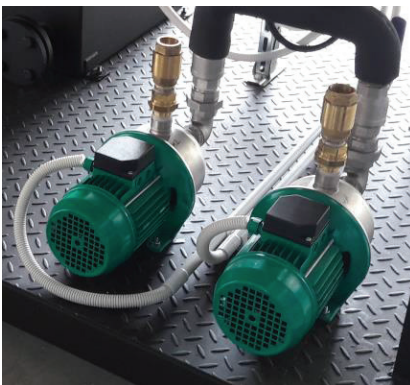
dvojice horkovodních čerpadel
