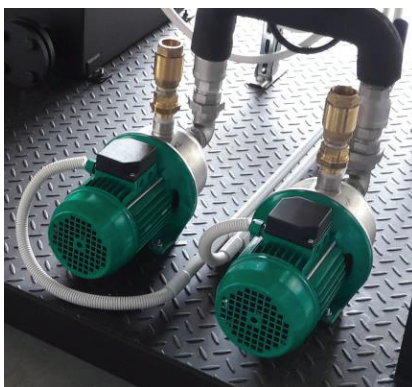
dvojice horkovodních čerpadel
